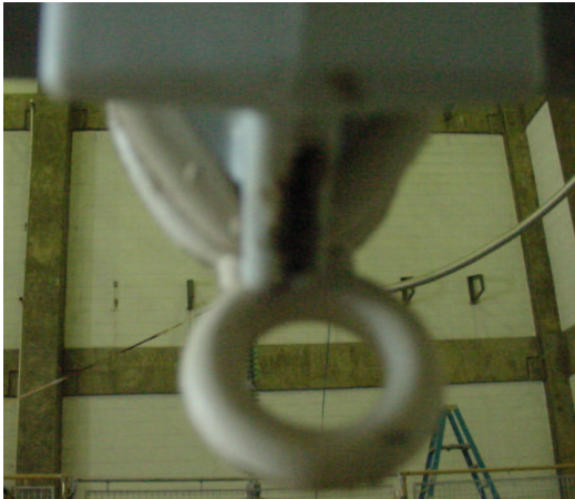
Figura 16 – Danos no espaçador 4 após ensaio de compatibilidade dielétrica com cabo 3
