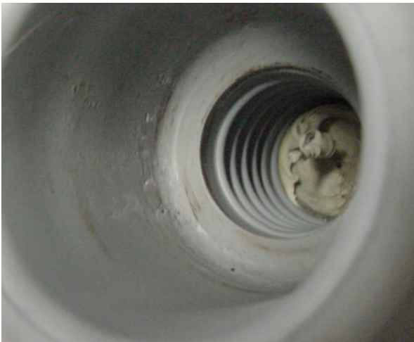
Figura 25 – Exemplo de dano observado na parte interna dos isoladores pino 2 a 5 após ensaio de compatibilidade dielétrica com cabo 1
