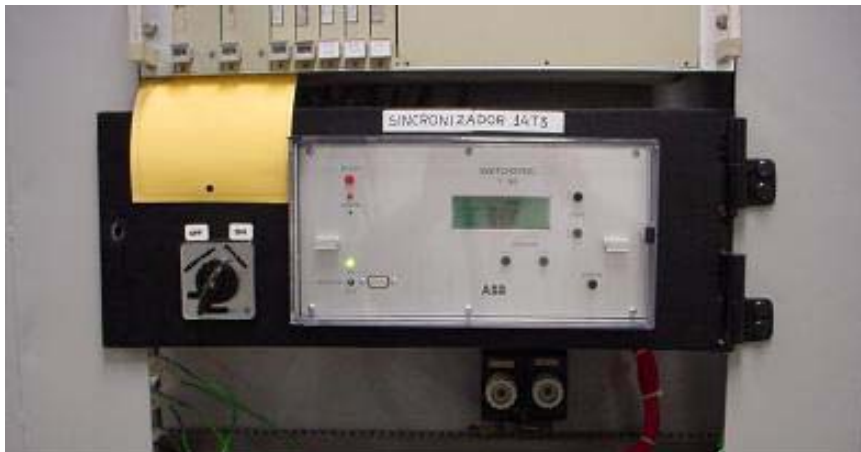
FIGURA 2 – Vista frontal do dispositivo "Switchsync TM " instalado provisoriamente na Subestação Eunápolis.
