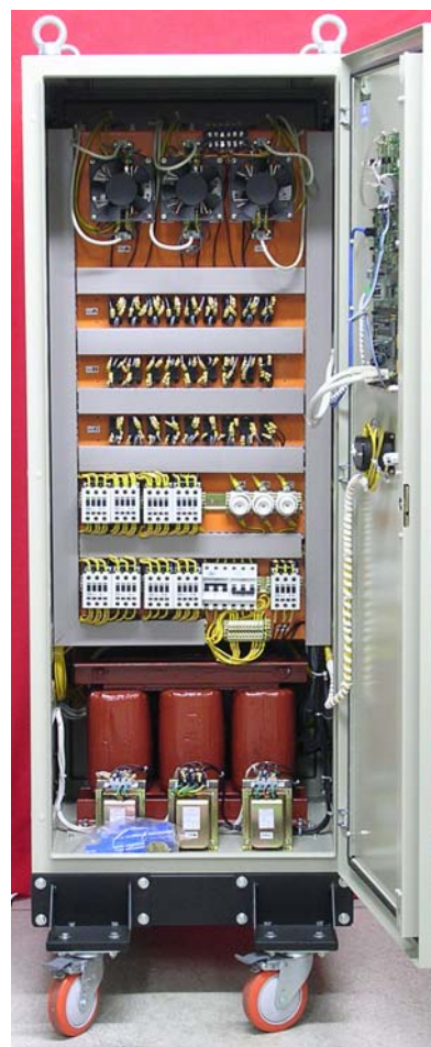
Figura 3 – Equipamento Montado em Rack
