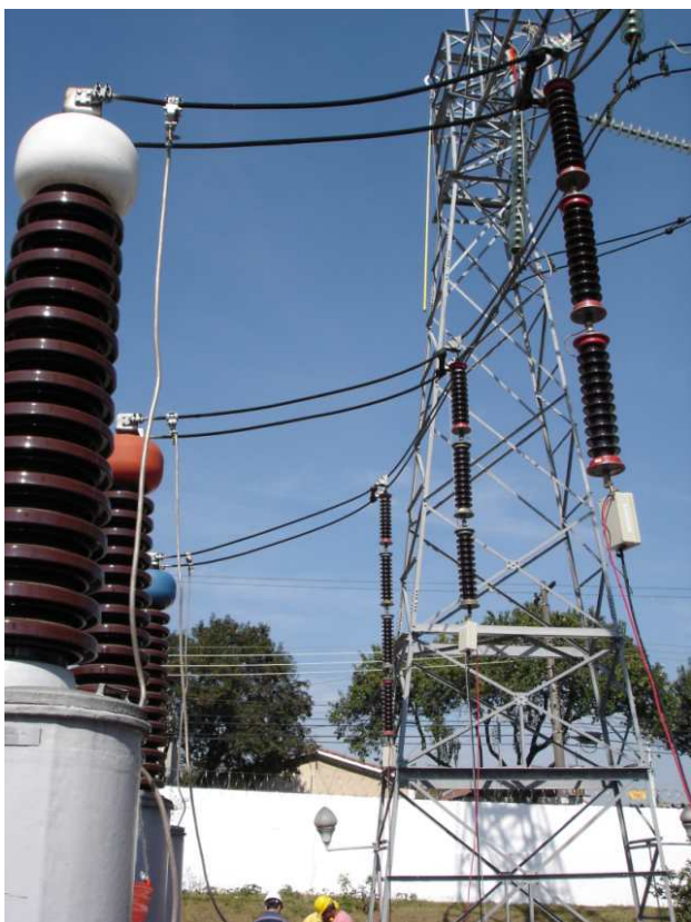
Figura 10 – Montagem no campo dos módulos do divisor capacitivo e MS-DPC – LTS Centro ETR 2313.
