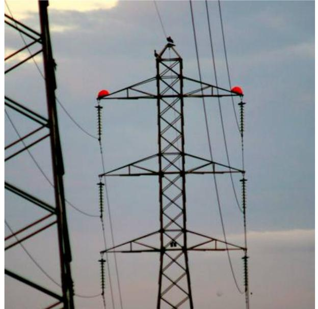
Figura 10 – Dispositivos anti pouso instalados em uma torre de transmissão.
