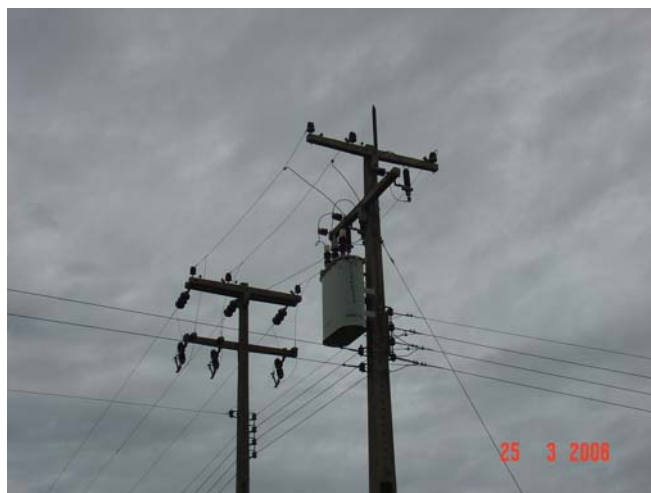
Figura 1 – Cabo de aterramento suplementar e haste para proteção de um transformador.
