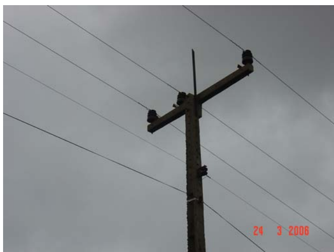
Figura 3 – Cabo de aterramento suplementar e haste para proteção de isoladores.
