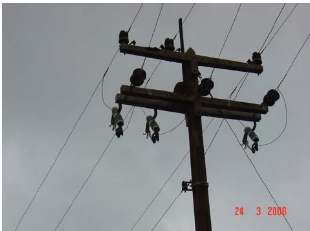
Figura 2 – Cabo de aterramento suplementar e haste para proteção de chaves e isoladores.
