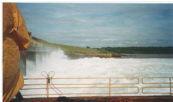
Figura 1. Ressonância hidráulica formada na UHE Porto Colômbia para a vazão de 4000 m 3 /s (número de Froude = 5,23).
