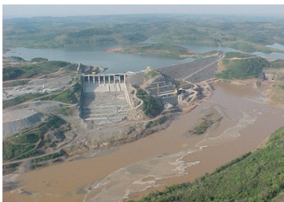
FIGURA 3 - VISTA DO EMPREENDIMENTO AO TÉRMINO DA OBRA - 2001.
