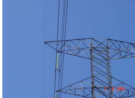
FIGURA. 12 – LT-230kV (V.Conde-Sta.Maria), da ELETRONORTE
