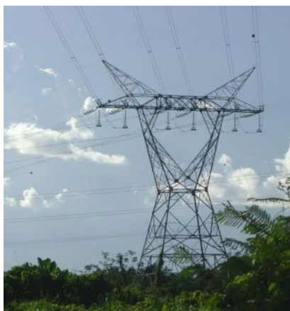
FIGURA 8 – LT-230 kV (V. Conde-Sta Maria), da ELETRONORTE
