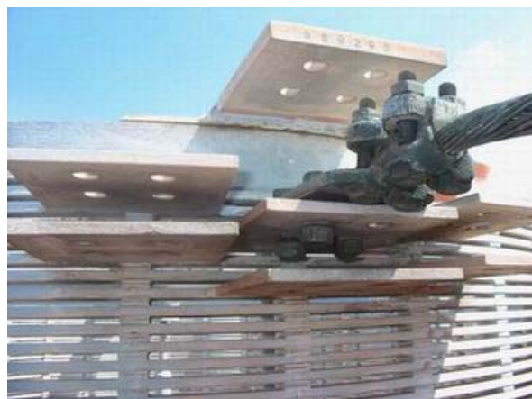
Figura 3: Taps do filtro de 5ª ordem (uma das fases)
