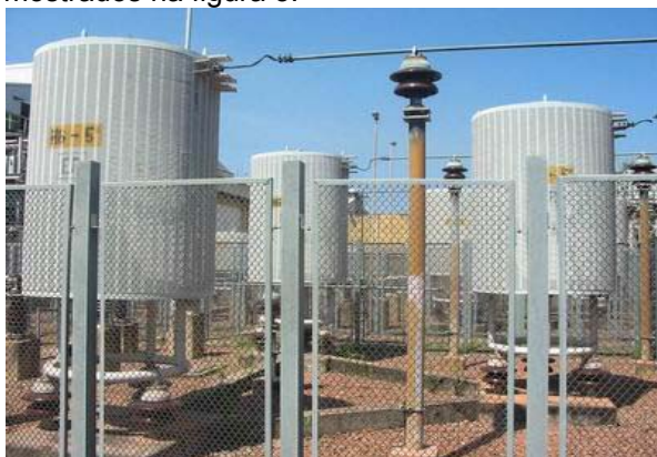
Figura 2: Filtro de 5ª ordem, onde ocorreram as trocas dos taps
