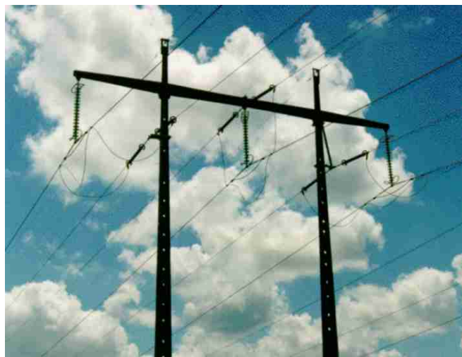
Figura 5 - Recapacitação da LT 230 kV do corredor Paulo Afonso Fortaleza, aumento da capacidade de transmissão em até 70 %
