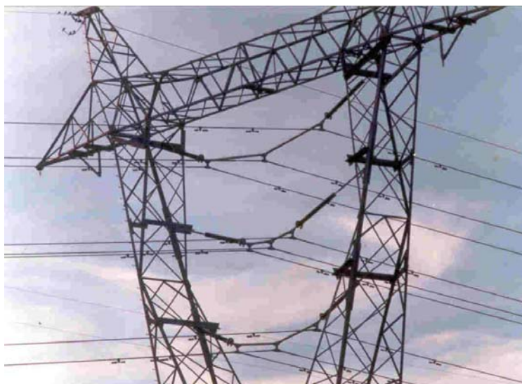
Figura 2 – LPNE piloto em 230 kV - CHESF
