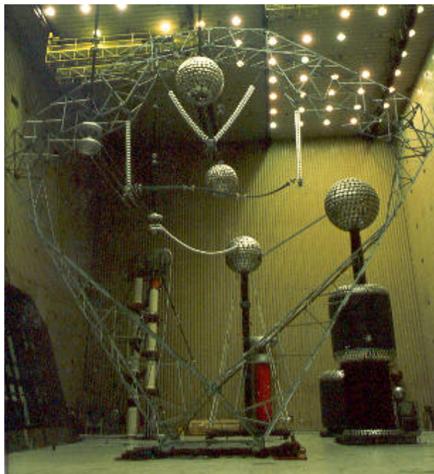
Figura 1 – torre “raquete” – padrão de 500 kV da ELETRONORTE, ensaio no CEPEL
