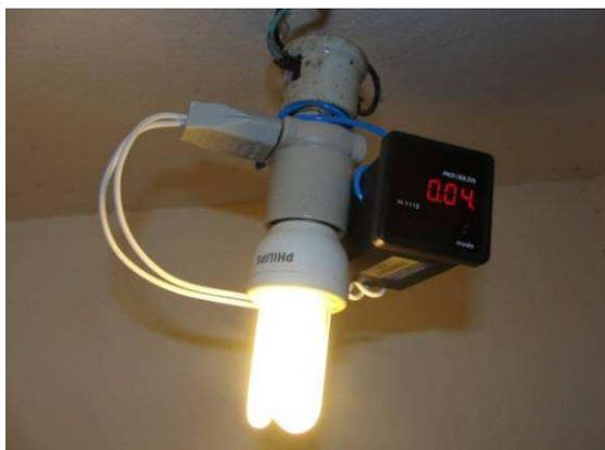
**Figura 17** – Registrador de tempo de uso/horímetro com contador eletromecânico, contagem progressiva e acumulativa, utilizado para medir o tempo de operação de equipamentos elétricos, possuindo 5 dígitos inteiros e dois fracionários, tensão nominal de 240 Vc.a. com faixa mínima de operação entre 80% a 110% da tensão nominal, frequência de 60 Hz, com montagem externa de 48 x 48 mm.
