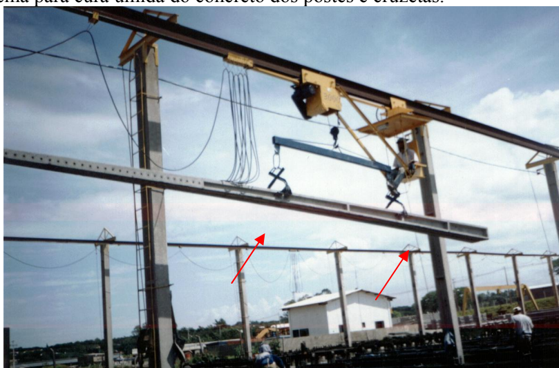
Figura 4 - Movimentação de poste recém retirado da forma. No detalhe o dispositivo (“gato”) de içamento em dois pontos.
