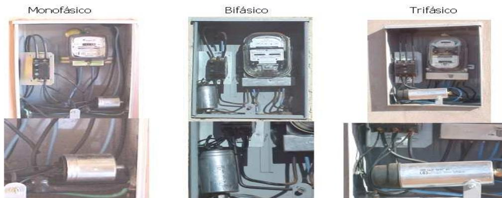
Figura 3: Capacitores instalados
