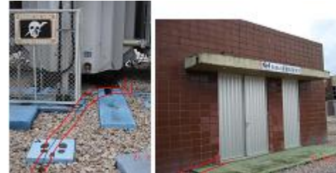
Figura 12 – Indicação do trajeto (em vermelho) do cabo de transmissão dos sinais de vibração.
