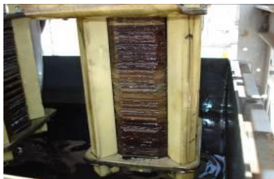
Figura 10: Câmara de extinção de arco
