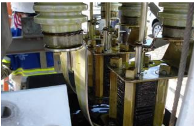
Figura 14: Câmara de extinção de arco e pé da bucha
