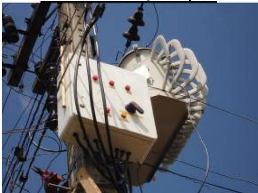
Foto 4: Dispositivo fixado no poste sob o Transformador.
