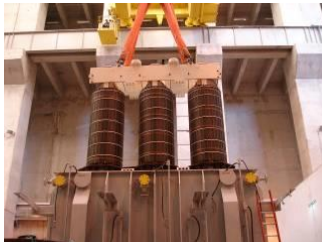
Figura 3. Retirada do núcleo.
