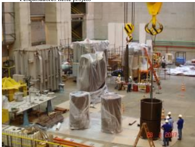
Figura 3. Estrutura utilizada para os procedimentos de desmontagem.
