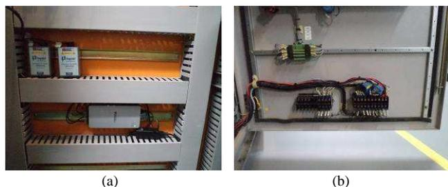
Figura 1. Instalação do cabeça-de-série no painel: (a) sistema de aquisição de dados e transdutores de tensão, (b) transdutores de corrente.
