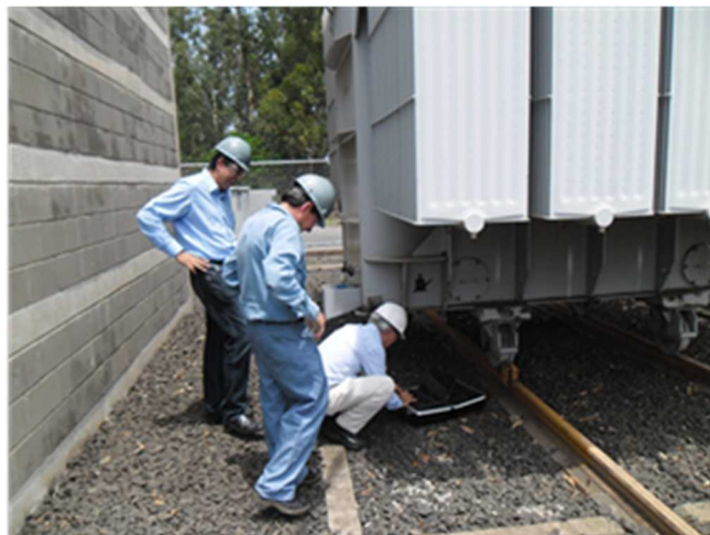
Figura 13. Instalação e teste no ponto 3 de aterramento (lado de 138kV).
