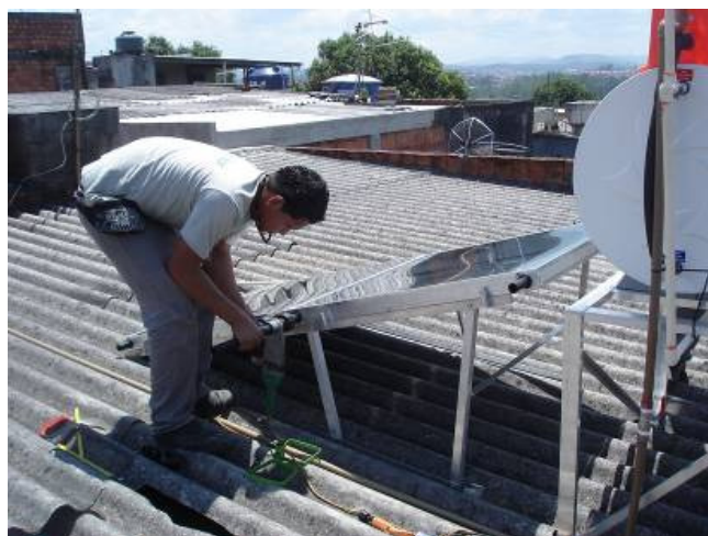
Figura 13. Obras durante a instalação do sistema solar de uma residência com cobertura de telha tipo "brasilit" que recobria a laje.
