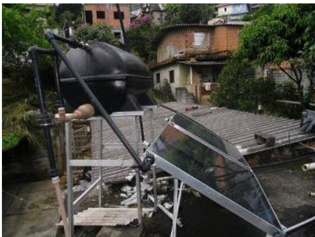
Figura 15. Instalação da 2ª experiência de campo, concluída, com reservatório e placas sobre suporte de alumínio.
