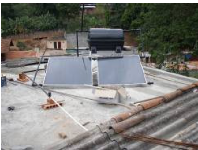
Figura 5. Instalação de um protótipo sobre a laje da casa.
